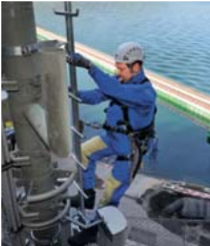
Regola 7 Usare le scale anticaduta in sicurezza
