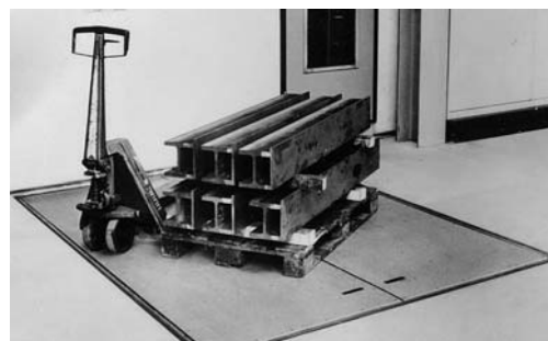
Figure 5: ouverture dans le plancher recouverte d'une trappe. La trappe est construite de sorte que sa charge admissible corresponde à celle du plancher environnant.
