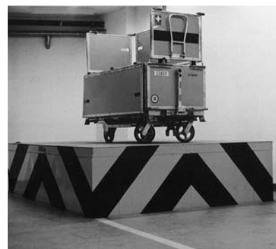
Fig. 6: des tabliers empêchent les personnes non autorisées d'accéder sous la plate-forme.
