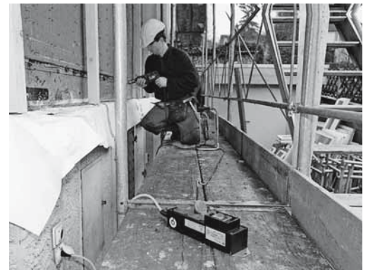
Bild 5: Wenn keine Baustromverteiler vorhanden sind: Mobile FI-Schalter anschliessen.
