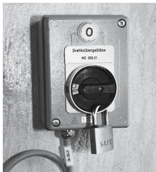
Bild 3: Sicherheitsschalter in der 0-Stellung mit einem persönlichen Vorhängeschloss gegen Wiedereinschalten gesichert.
