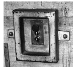
Bild 4: Eingemauerte oder mit einem robusten Rahmen versehene Bedienungsorgane sind gegen das Angefahrenwerden von Fahrzeugen geschützt.
